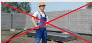
Hardie® VL Plank brædder leveres stukket ind i hinanden. Facadebrædderne skal derfor først trækkes ud sideværts, før de må løftes af pallen.
