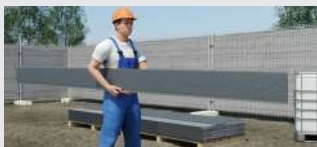
Facadebrædderne skal altid bæres på højkant.
