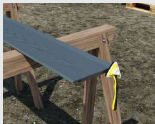
Påføring af HardieSeal™ kantforsegling før montagen.
