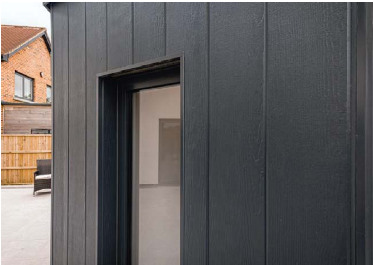
Hardie® VL Plank - vertikal sammenføyning. Farge: svart
